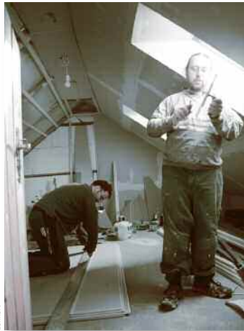
Alles neu macht der November – Mirko (am Fenster), ein ehrenamtlicher Helfer, und Johannes beim Werkeln im Dachstübchen
