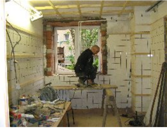
Fenstereinbau für den neuen Gesprächsraum in Tauscha
