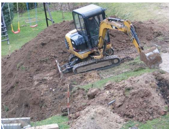
Baubeginn des Terrassenbaus in Tauscha
